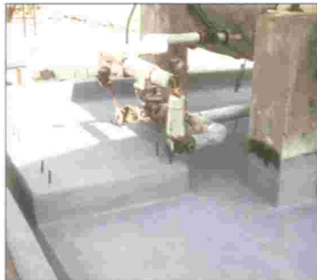
AREAS DE ALMACENAMIENTO DE QUÍMICOS
