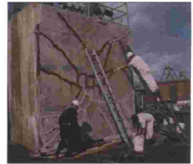
TANQUES AGRIETADOS
