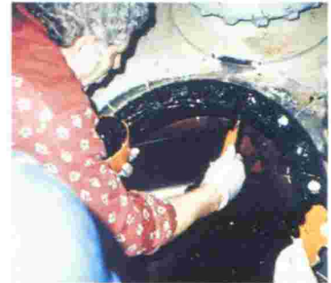
REPARACIÓN DE FORROS DE CAUCHO
