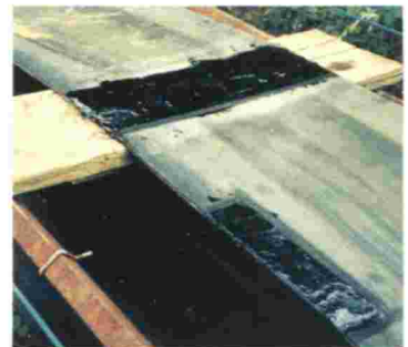
REPARACIÓN DE BANDAS TRANSPORTADORAS
