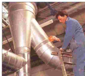
SELLADO DE CONDUCTOS DIVIDIDOS
