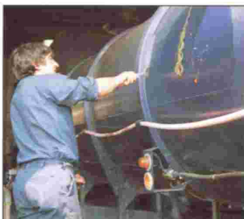
SELLADO DE TANQUES CON FILTRACIONES
