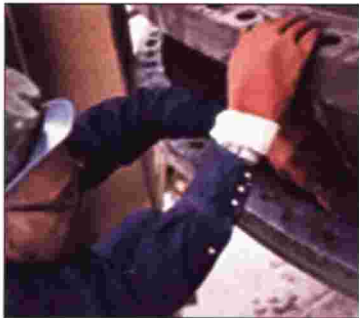
REFORMAR BRIDAS DISTORCIONADAS
