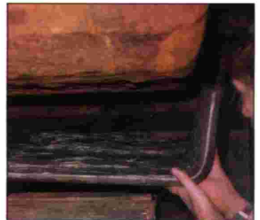
SELLAR PLACAS DE REFUERZO
