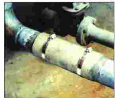
REPARACION DE TUBERIAS PERFORADAS
