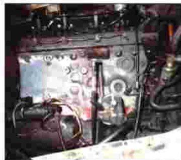
REPARACION DE BLOQUES AGRIETADOS
